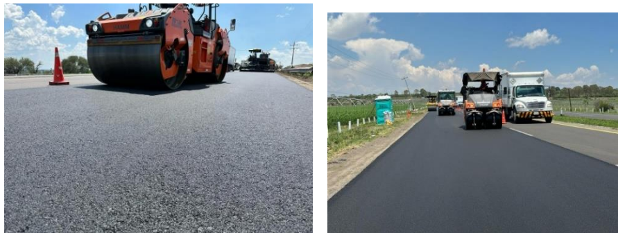
Figura 8. pavimentación del tramo piloto en RCO
